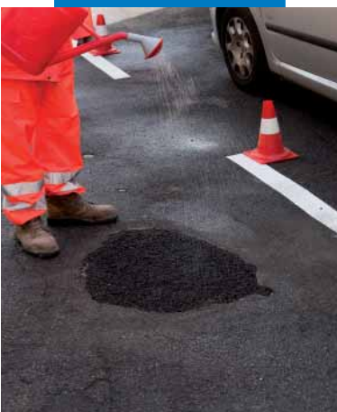
Vlhčení povrchu Mape-Asphaltu Repair 0/8
