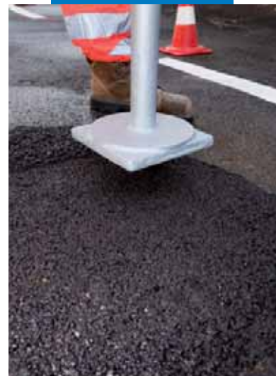
Ruční hutnění Mape-Asphaltu Repair 0/8
