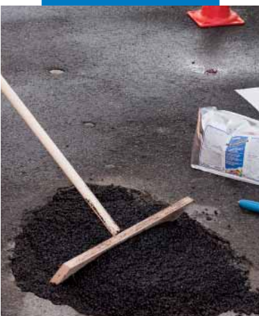
Aplikace a rozprostření Mape-Asphaltu Repair 0/8
