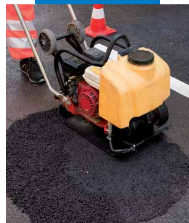
Strojní hutnění Mape-Asphaltu Repair 0/8
